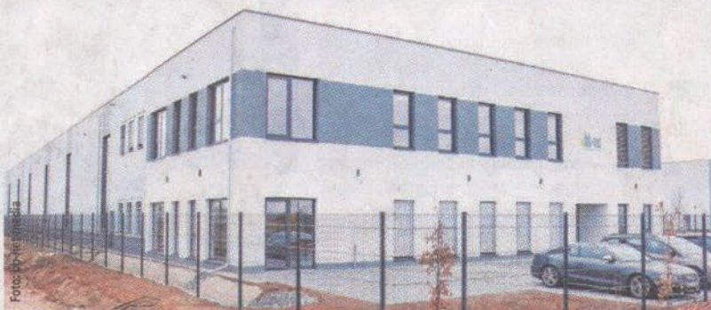
Die neue bb-net Zentrale vereint alle Unternehmensbereiche unter einem Dach.
